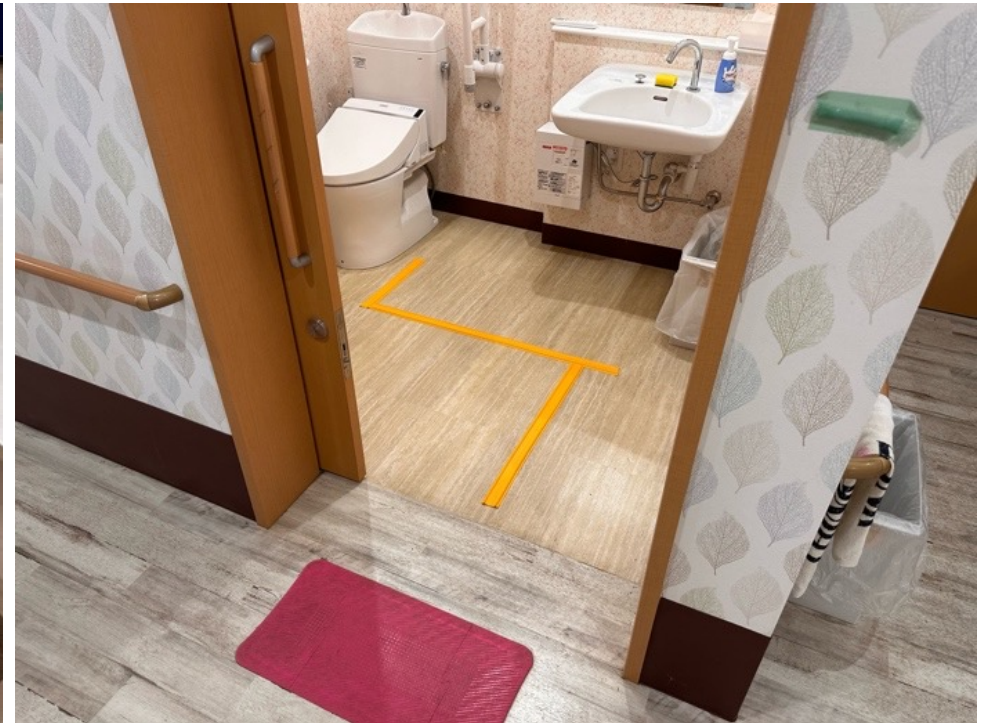
トイレ内をライン貼り
