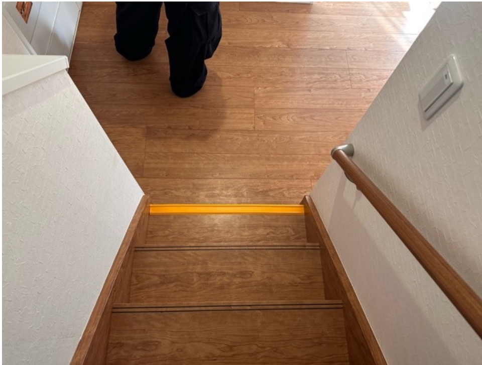
階段のスタートラインにポイント貼り
