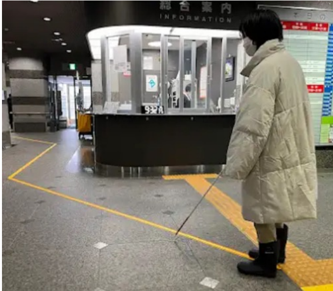
入口点字ブロックからEVまでをライン貼り
