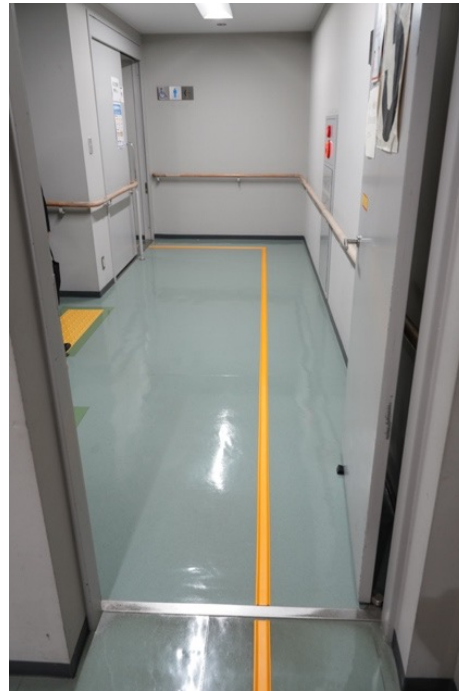
手すりに沿ってライン貼り
